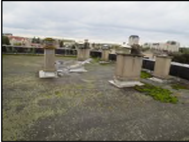
Photo N° 141 ECH-N°2 --Toiture Planchers Etanchéité bitumineux
