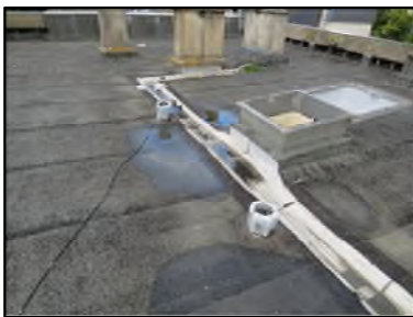
Photo N° 98 AMIANTE CIMENT -- Toiture Conduits de ventilation Ventilation haute (Fibres-ciment)
