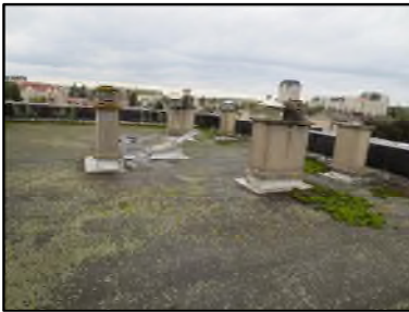
Photo N° 141 ECH-N°2 --Toiture Planchers Etanchéité bitumineux
