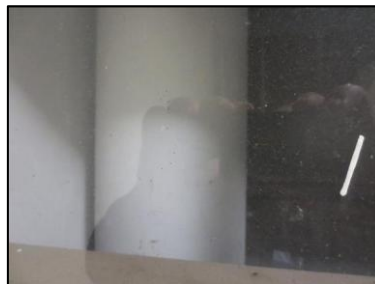
Photo N° 694 AMIANTE CIMENT 7 SAINT EXUPERY-RDC à +4-LOCAL V.O Vide-ordures Gaine V.O.(Fibres- ciment)
