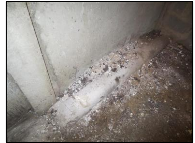
Photo N° 702 AMIANTE CIMENT 15 LORIENT-S.sol-COULOIRS DE CAVES Conduits de fluide Chute E.U.(Fibres-ciment)
