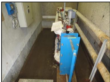
Photo N° 706 ECH-N°008 CALORIFUGEAGE SOUS STATION 15 LORIENT-S.sol-SOUS STATION Conduits de fluide Laine minérale + enveloppe plâtrée
