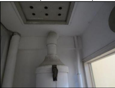
Photo N° 705 AMIANTE CIMENT 17 LORIENT- +4-LOCAL V.O Plafonds Ventilation haute (Fibres-ciment)
