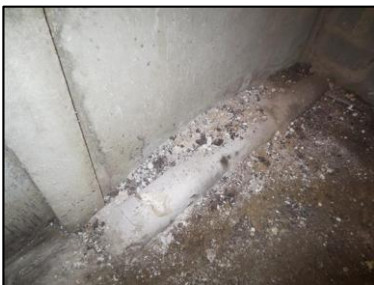
Photo N° 702 AMIANTE CIMENT 17 LORIENT-S.sol-COULOIRS DE CAVES Conduits de fluide Chute E.U.(Fibres-ciment)
