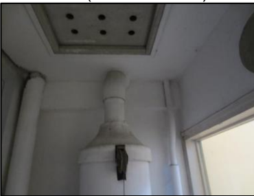
Photo N° 705 AMIANTE CIMENT 19 LORIENT+4-LOCAL V.O Plafonds Ventilation haute (Fibres-ciment)
