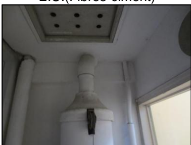
Photo N° 705 AMIANTE CIMENT 21 LORIENT +4-LOCAL V.O Plafonds Ventilation haute (Fibres-ciment)
