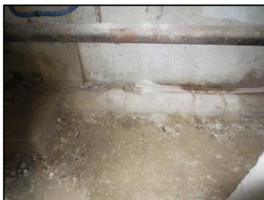
Photo N° 708 AMIANTE CIMENT 2 BLAISE-S.sol-COULOIRS DE CAVES Conduits de fluide Chute E.U.(Fibres-ciment)
