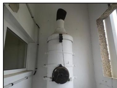
Photo N° 711 AMIANTE CIMENT 2 BLAISE-+1 à +4-LOCAL V.O Vide- ordures Gaine V.O.(Fibres-ciment)
