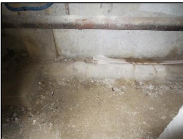
Photo N° 708 AMIANTE CIMENT 8 BLAISE-S.sol-COULOIRS DE CAVES Conduits de fluide Chute E.U.(Fibres-ciment)
