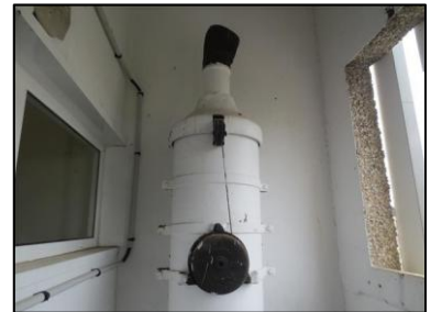
Photo N° 711 AMIANTE CIMENT 8 BLAISE--LOCAL V.O RDC à +4 Vide-ordures Gaine V.O.(Fibres-ciment)
