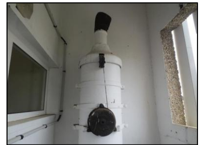
Photo N° 711 AMIANTE CIMENT 10 BLAISE--LOCAL V.O RDC à +4 Vide-ordures Gaine V.O.(Fibres-ciment)
