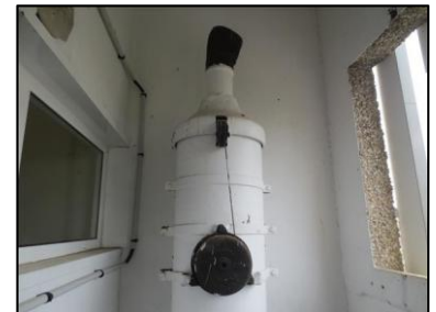
Photo N° 711 AMIANTE CIMENT 10 BLAISE--LOCAL V.O RDC à +4 Vide-ordures Gaine V.O.(Fibres- ciment)
