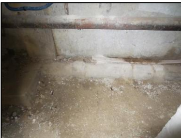
Photo N° 708 AMIANTE CIMENT 10 BLAISE-S.sol-COULOIRS DE CAVES Conduits de fluide Chute E.U.(Fibres-ciment)
