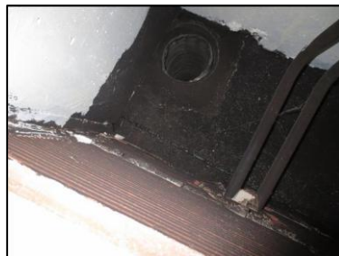
Photo N° 710 AMIANTE CIMENT 16 BLAISE--PLACARDS +4 Plafonds Ventilation haute (Fibres-ciment)
