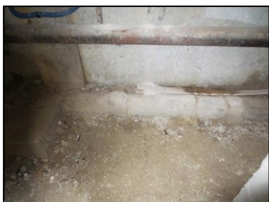
Photo N° 708 AMIANTE CIMENT 16 BLAISE-S.sol-COULOIRS DE CAVES Conduits de fluide Chute E.U.(Fibres-ciment)
