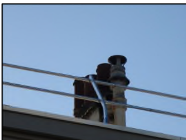
Photo N° 158 AMIANTE CIMENT -- Toiture Conduits de Ventilation Ventilation haute (Fibres-ciment)
