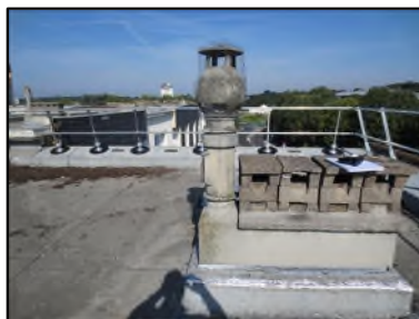
Photo N° 37 AMIANTE CIMENT -- Terrasse Conduits Ventilation haute (Fibres-ciment)
