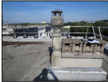
Photo N° 37 AMIANTE CIMENT -- Terrasse Conduits Ventilation haute (Fibres-ciment)
