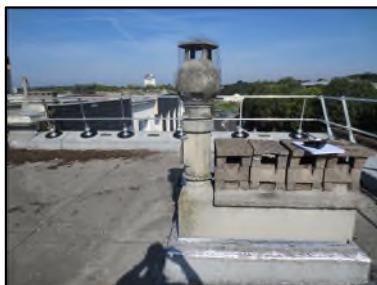
Photo N° 37 AMIANTE CIMENT -- Terrasse Conduits Ventilation haute (Fibres-ciment)
