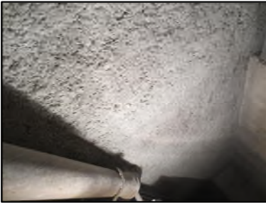
Photo N° 32 ECH-N°1 FLOCAGE -- Sous sol Plafonds Flocage
