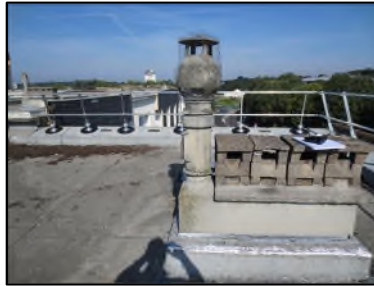
Photo N° 37 AMIANTE CIMENT -- Terrasse Conduits Ventilation haute (Fibres-ciment)
