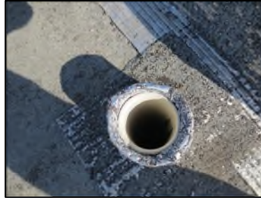
Photo N° 36 AMIANTE CIMENT -- Toiture Terrasse Conduits Ventilation haute (Fibres-ciment)
