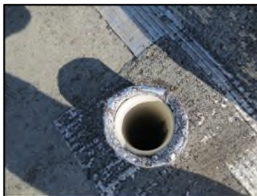
Photo N° 36 AMIANTE CIMENT -- Toiture Terrasse Conduits Ventilation haute (Fibres-ciment)
