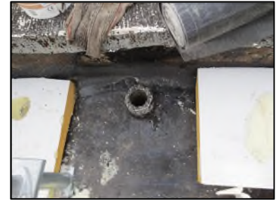
Photo N° 47 AMIANTE CIMENT -- Toiture Planchers Ventilation haute (Fibres-ciment)
