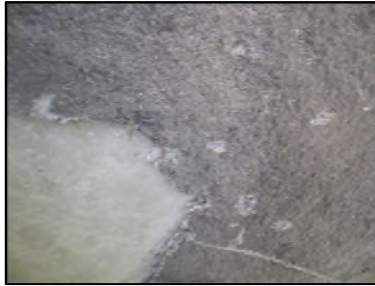
Photo N° 528 ECH-N°3 FLOCAGE SOUS SOL Plafonds FLOCAGE
