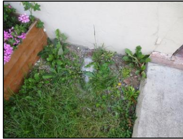
Photo N° 1186 AMIANTE CIMENT -- façade entrée sol Chute E.U.(Fibres- ciment)
