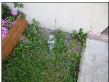
Photo N° 1186 AMIANTE CIMENT - -façade entrée sol Chute E.U.(Fibres-ciment)
