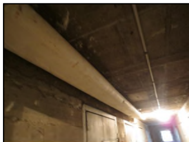
Photo N° 427 ECH-N°1 CALORIFUGEAGE COULOIR DE CAVE Conduits de fluide Laine minérale + enveloppe plâtrée
